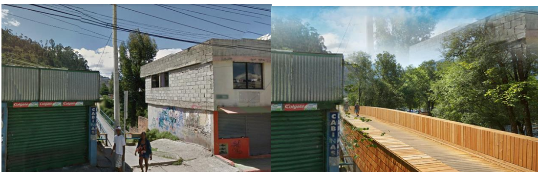
Puente peatonal hacia el barrio San Vicente
